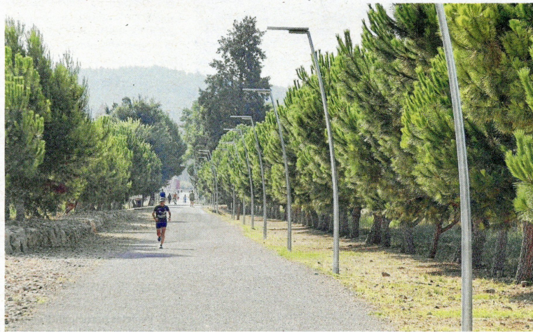
Tram de la Via Verda al terme de Tortosa. FOTO: JOAN REVILLAS
