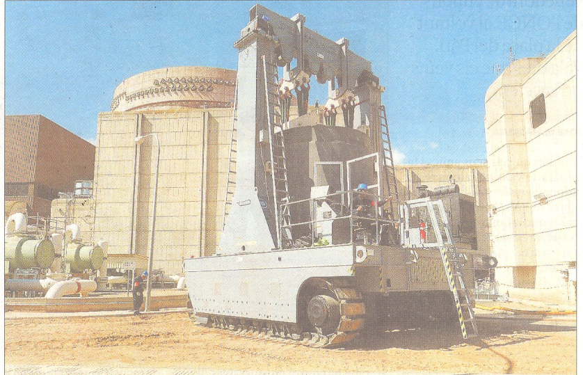
Aparell de transport del combustible gastat, des de les piscines al nou magatzem. FOTO: ANAV
