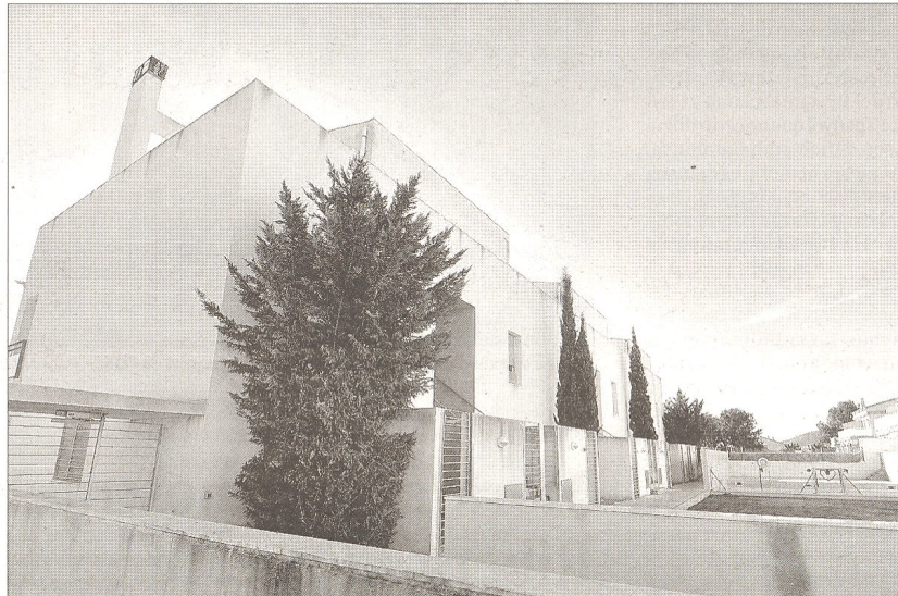
Imatge dels habitatges que el Jutjat insta a enderrocar. FOTO: JOAN REVILLAS
