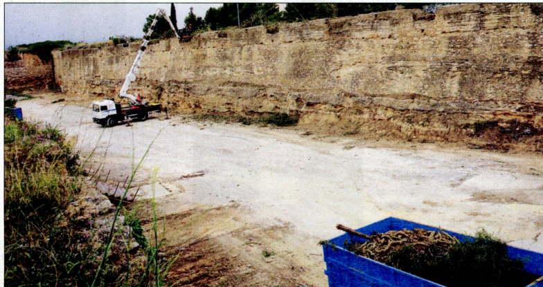
Les màquines i els operaris han començat a desbrossar la part alta de la muralla. / NÚRIA CARO
