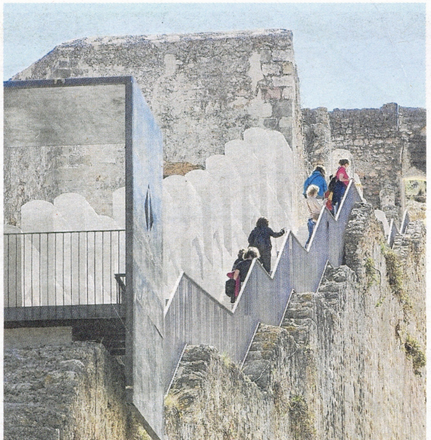
La muralla del Rastre, rehabilitada per l'Ajuntament. FOTO: J. REVILLAS
