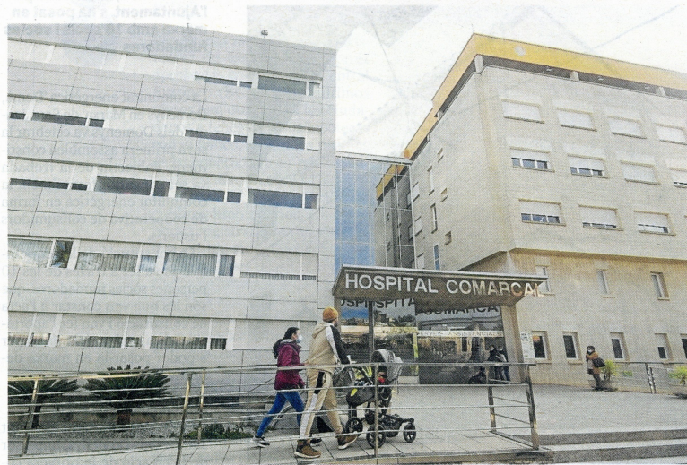
Entrada principal a l'Hospital Comarcal d'Amposta. FOTO: JOAN REVILLAS
