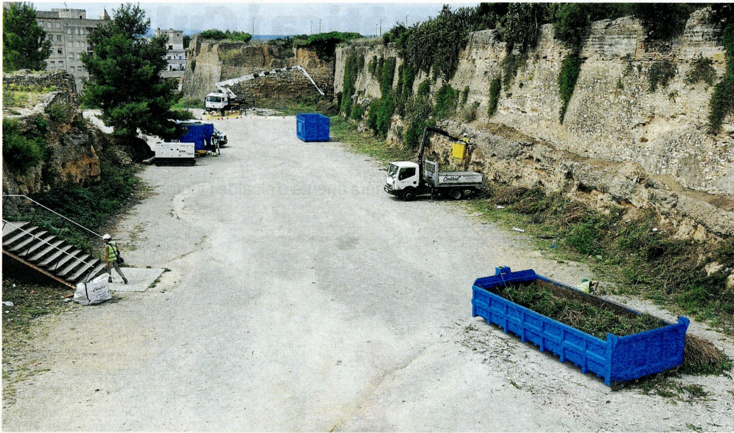
Els treballs al fossat van començar ahir, amb el desbrossament de vegetació al talús. FOTO: J. REVILLAS
