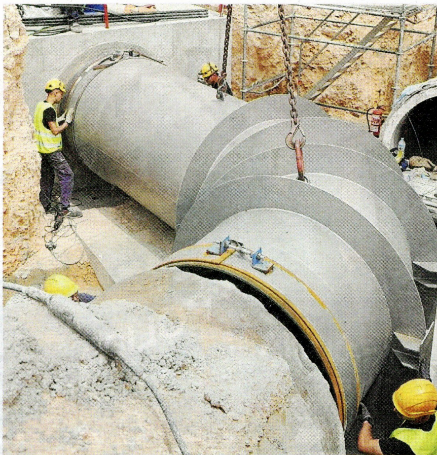
Obres de construcció del nou tram de canonada. FOTO:CAT
