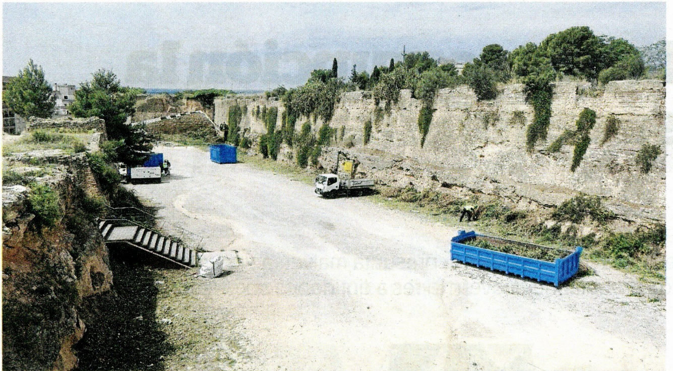
Els treballs al fossat per ara se centren en la neteja de vegetació de la muralla. FOTO: J. REVILLAS
