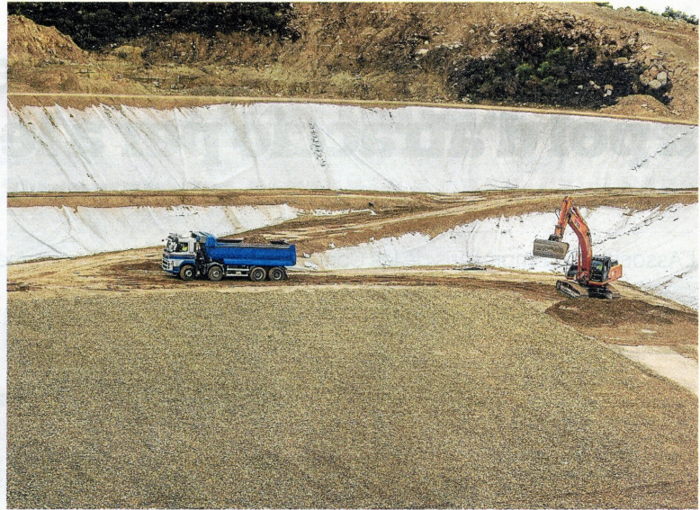
El dipòsit de residus en el moment de la seua construcció, a set quilòmetres de Riba-roja d'Ebre.
