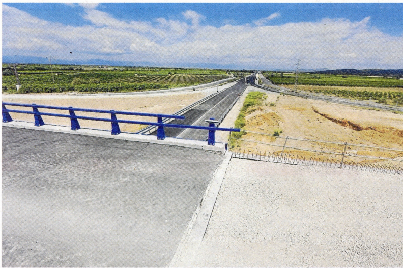
Obres a l'N-238, en el punt de connexió amb la població d'Alcanar. FOTO: JOAN REVILLAS
