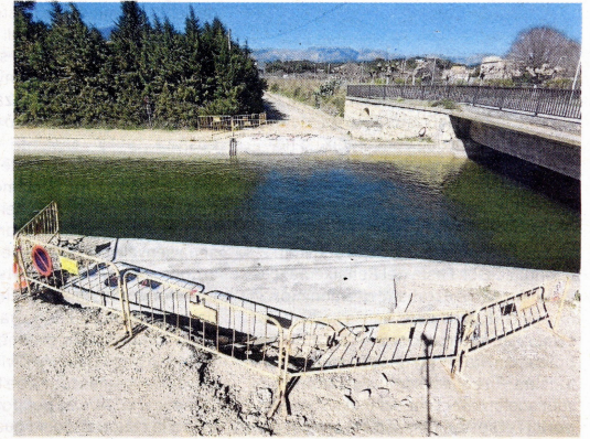
Les obres de substitució del pont costaran 90.000 euros FOTO: J.REVILLAS
