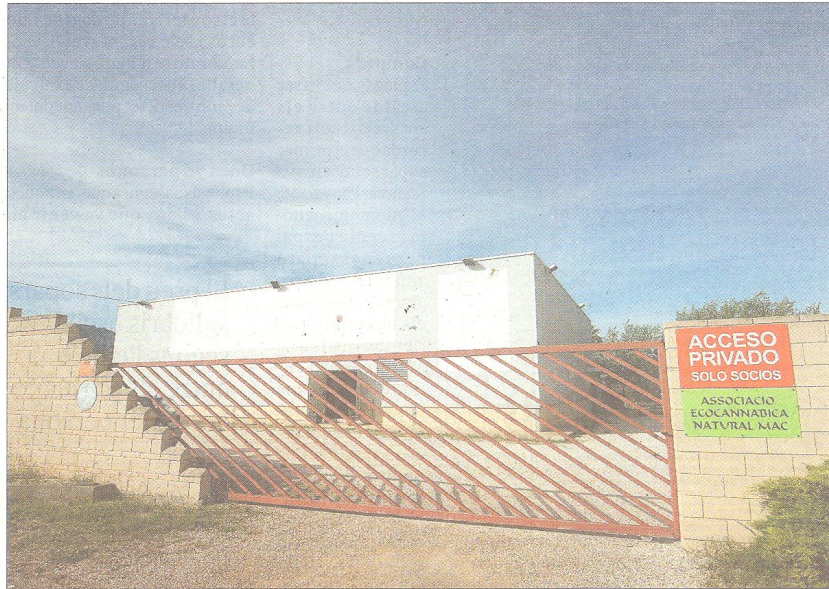
El primer club cannàbic ebrenç, a les instal·lacions de l'antiga discoteca Magnesia. FOTO: JOAN REVILLAS
