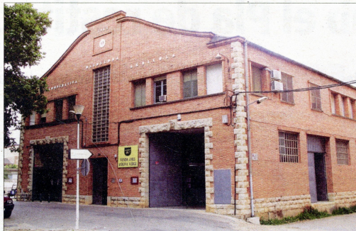
Antic edifici de la Cooperativa Agrícola d'Uldecona. / VÍCTOR MONTECINO VALLS
