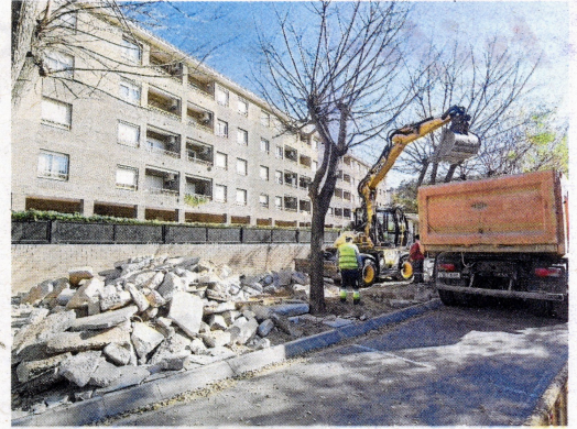
Treballs al carrer Soriano Montagut, aquesta setmana. FOTO: J. REVILLAS
