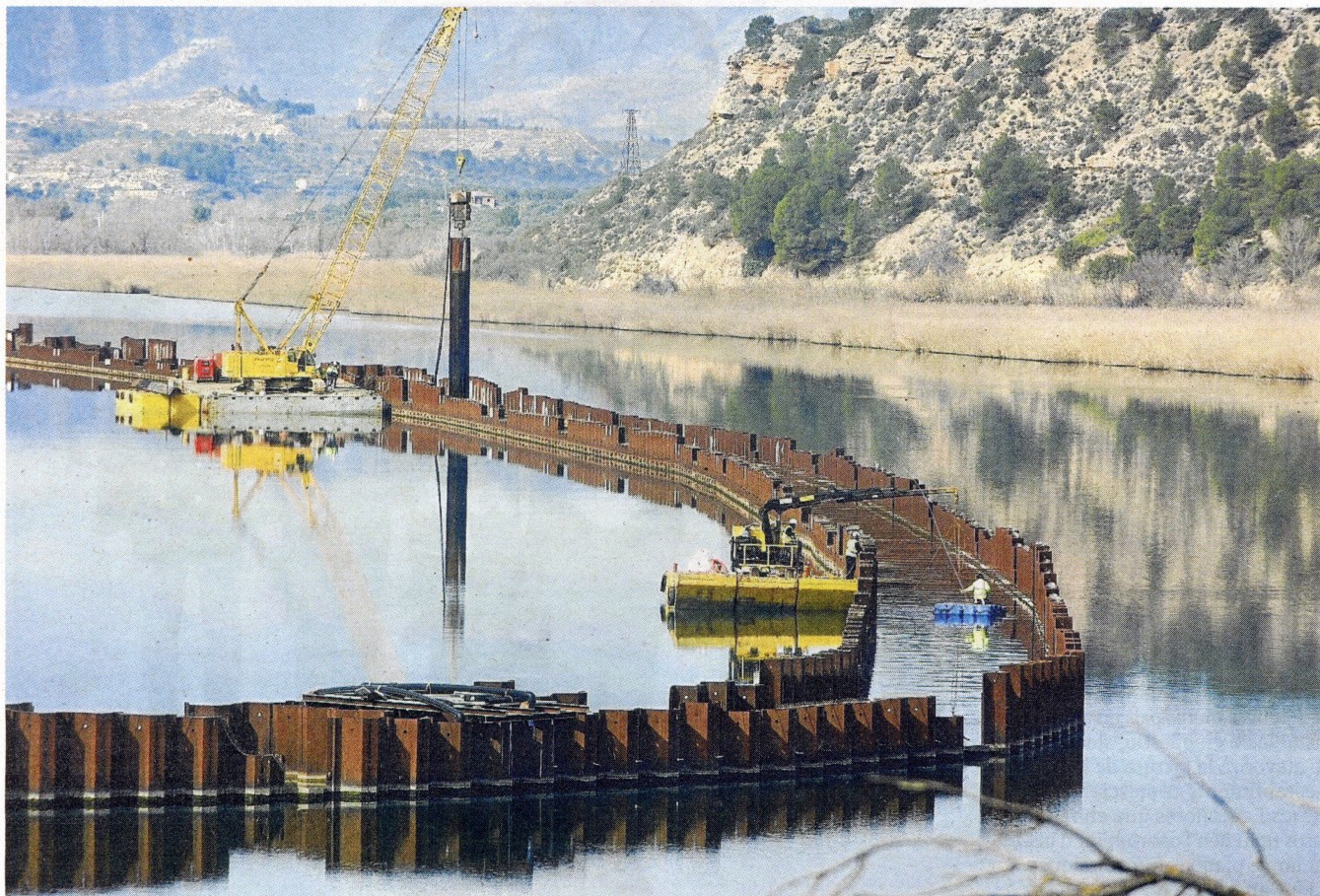
Treballs de retirada del tancament del pantà de Flix, actualment en executió. FOTO: JOAN REVILLAS
