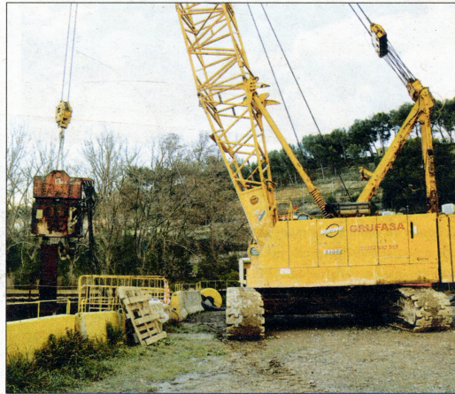
La retirada d'una de les palplanxes del tancat de Flix. / FOTO: ACN
