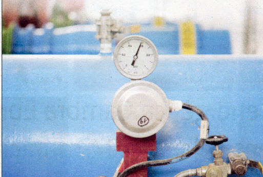
Estació de bombament a les instal·lacions del CAT.
