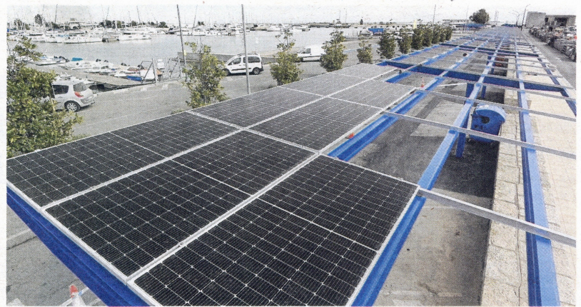
Detall dels panells fotovoltaïcs que s'estan instal·lant al port de la Ràpita. FOTO: J. REVILLAS
