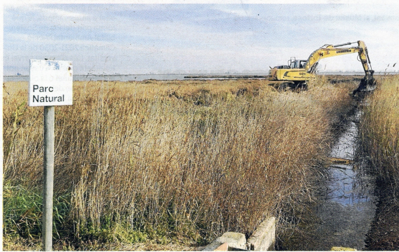
Maquinària treballant per incrementar l'alçada dels dics ja existents, vora l'Encanyissada. FOTO: J. REVILLAS
