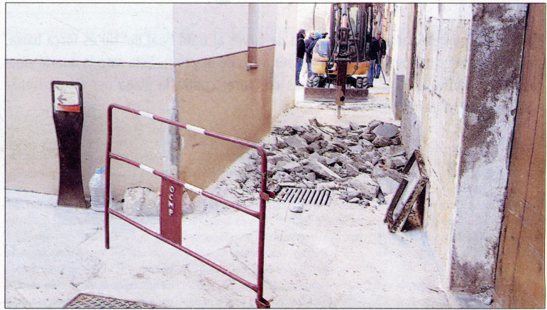
Les obres al carrer Vilanova, esta setmana.
