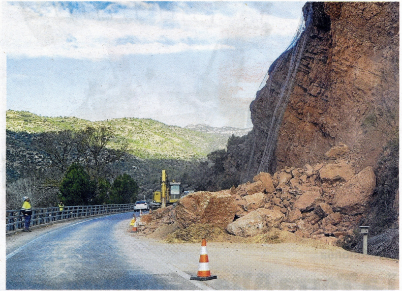
Estat de les obres a la C-12 al terme municipal de Garcia.
