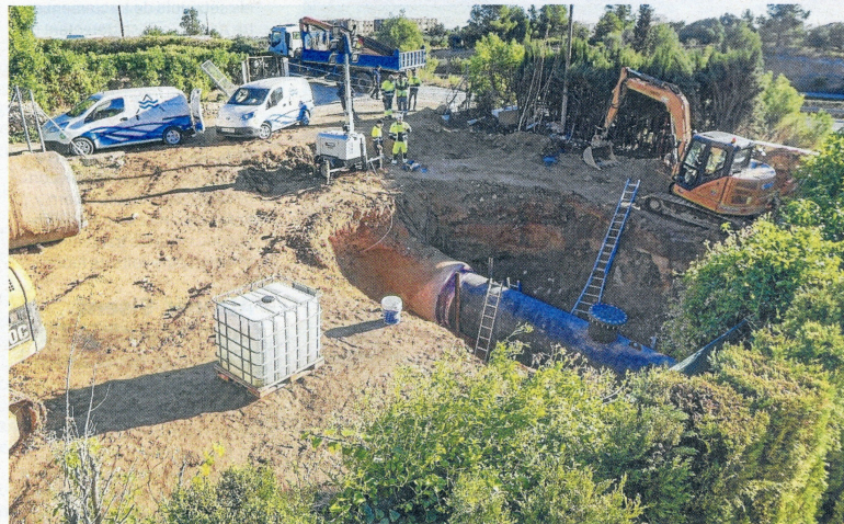
Imatge de les obres de l'anterior reparació de la canonada a l'Ametlla de Mar, el 2021. FOTO: JOAN REVILLAS
