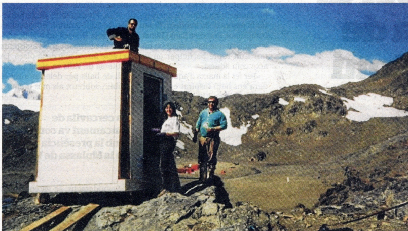
Muntatge d'una de les casetes que albergarien l'observatori geomagnètic, el 1995. FOTO: OBSERVATORI DE L'EBRE
