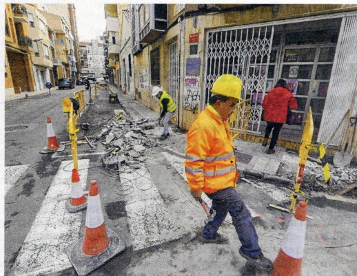
Obres al carrer Ciutadella del barri del Temple. FOTO: JOAN REVILLAS
