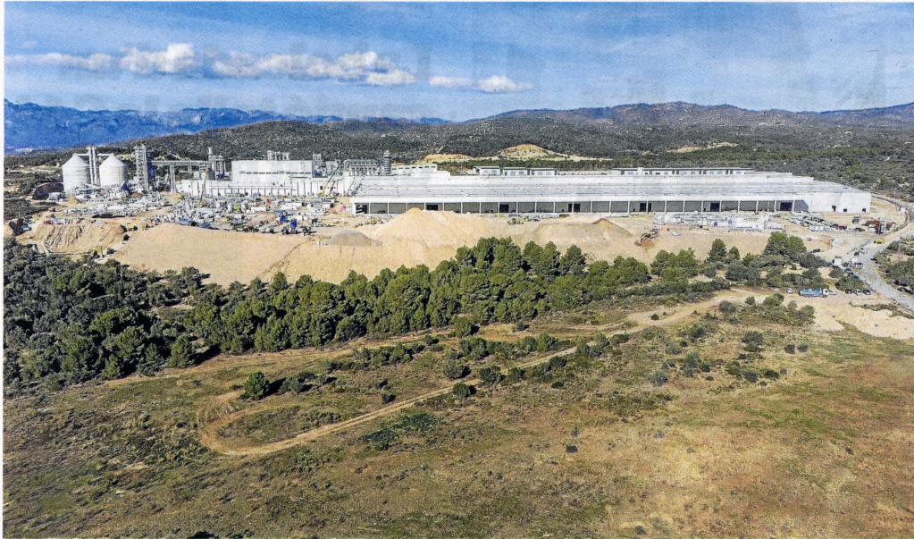
Estat actual de la construcció de la fàbrica de Kronospan al polígon Catalunya Sud. FOTO: JOAN REVILLAS
