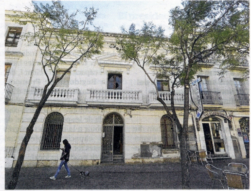
El Centre d'Economia Blava, actualment en obres. FOTO: JOAN REVILLAS
