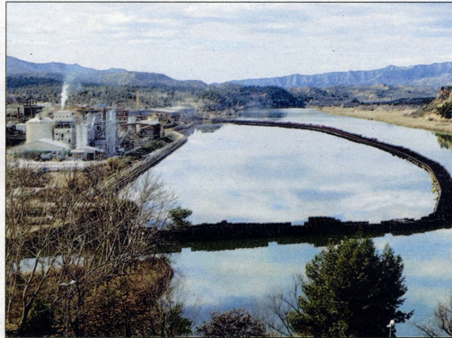
El tancat de palplanxat es començarà a retirar el proper mes de febrer
