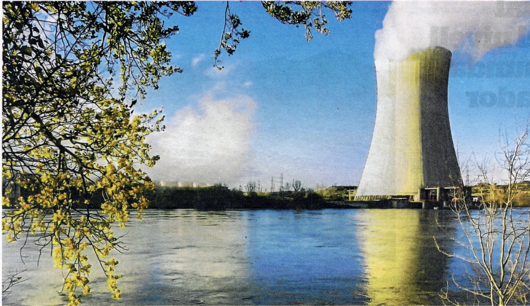
La central nuclear d'Ascó amb la seua torre de refrigeració a tocar del riu Ebre. FOTO: JOAN REVILLAS
