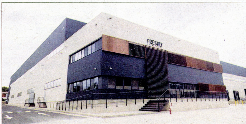
La nau de Freshly, al polígon industrial de Gandesa. / ACN
