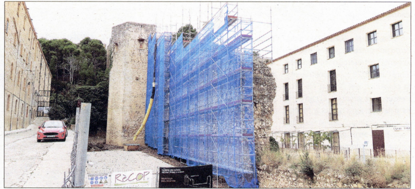
Imatge de les obres de rehabilitació de la muralla.
