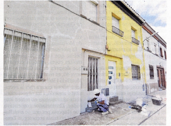
Operaris treballant en la rehabilitació de les façanes. FOTO: J. REVILLAS
