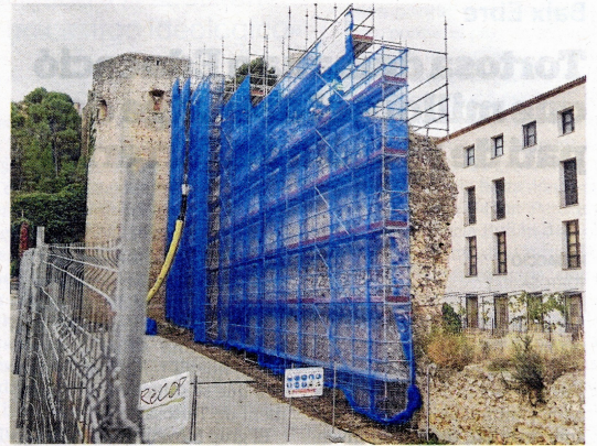
Bastides instal·lades i operaris treballant a la muralla. FOTO: J. REVILLAS
