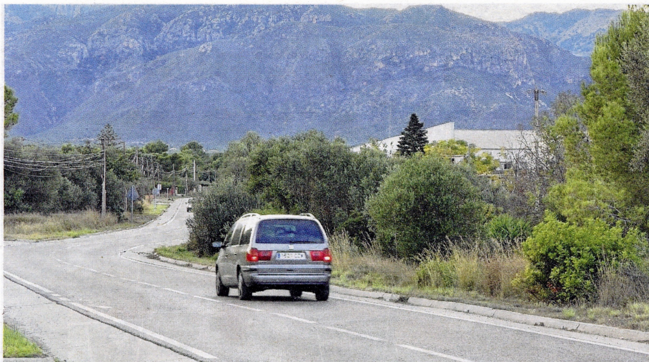
Tram de la carretera on es faran millores. FOTO: JOAN REVILLAS
