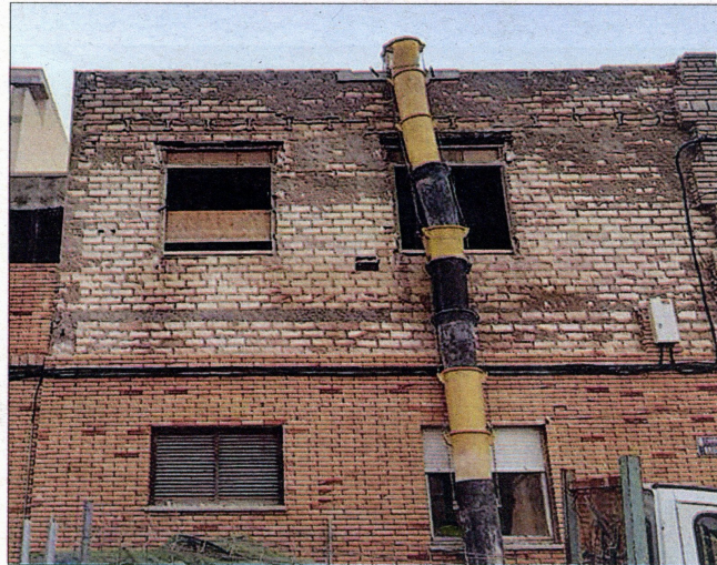
Edifici en obres de les antigues oficines del Port de l'Ametlla de Mar. / ACN
