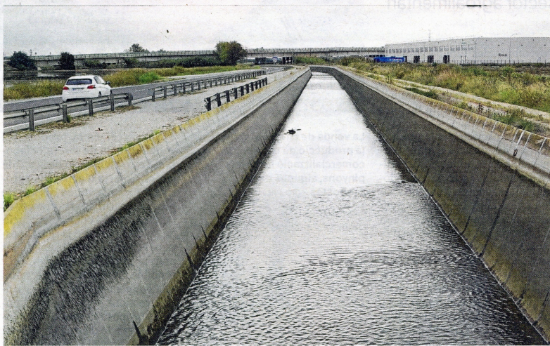
Procés de buidat del canal de l'esquerra de l'Ebre, al pas pel terme de l'Aldea. FOTO: JOAN REVILLAS
