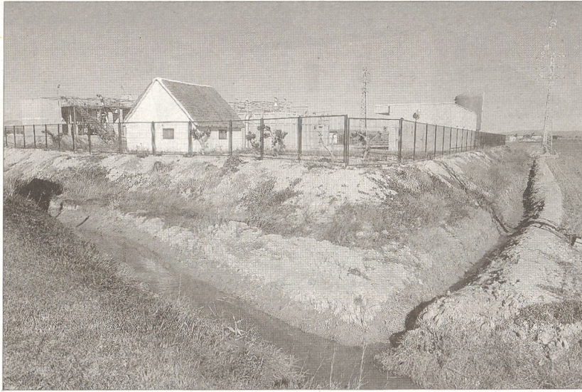
Imatge de la depuradora d'aigües residuals de Sant Jaume, una obra de 4,1 M€ sense utilitzar. FOTO: JOAN REVILLAS
