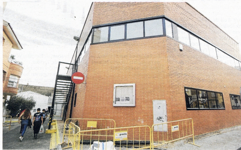
La previsió és que les obres s'allarguen durant uns dos mesos. FOTO: JOAN REVILLAS
