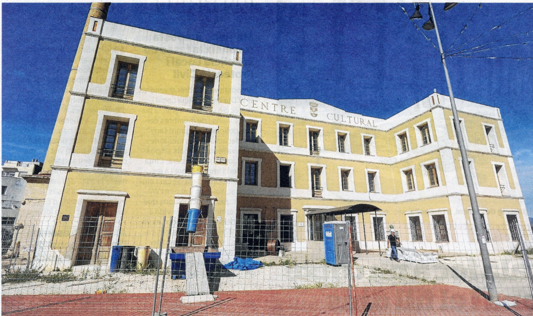
L'edifici de la biblioteca en procés de restauració. FOTO: JOAN REVILLAS
