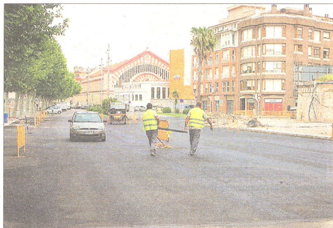
El nou asfaltat ja cobreix l'avinguda de Lleida, oberta de nou al pas de vehicles. FOTO: JOAN REVILLAS
