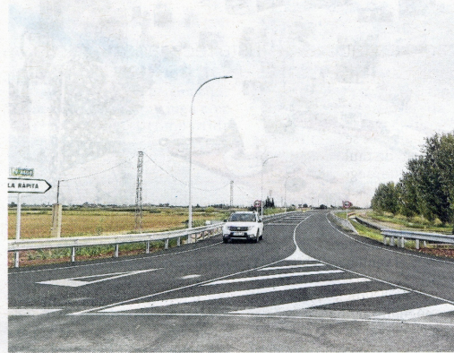
Estat actual de la TV-3408, després de la millora. FOTO: JOAN REVILLAS
