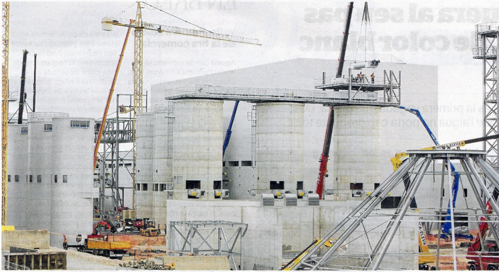
Estat actual de les obres de construcció de la gran planta, al polígon industrial Catalunya Sud. FOTO: JOAN REVILLAS
