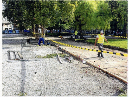
Obres a la plaça de les Corts Catalanes, al Temple. FOTO: JOAN REVILLAS
