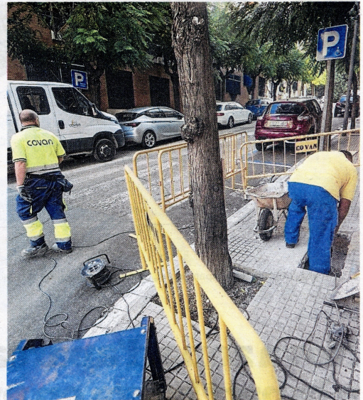
Operaris en els primers treballs, ahir al matí. FOTO: J. REVILLAS
