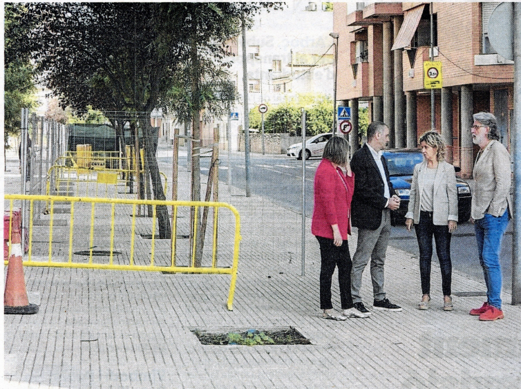
L'actuació inclou la instal·lació de dos canalitzacions d'aigua de gran capacitat. FOTO: JOAN REVILLAS
