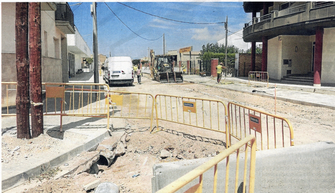
Obres de millora de carrers a l'avinguda de la Pau de Deltebre, aquest estiu. FOTO: JOAN REVILLAS
