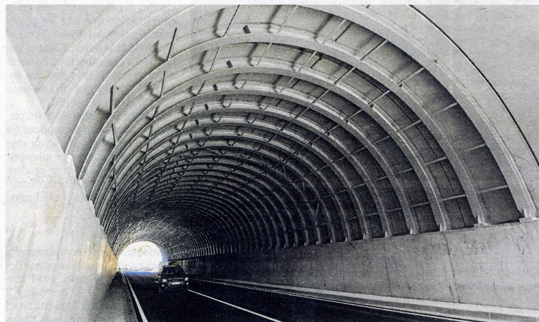
Detall de tot el reforçament de l'estructura a l'interior del túnel. FOTO: JOAN REVILLAS
