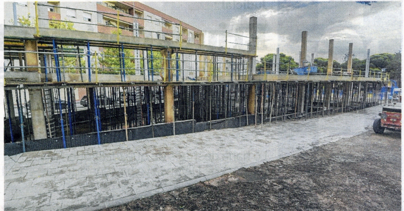
Estat de les obres del nou edifici al Parc del Bon Repòs. FOTO: JOAN REVILLAS
