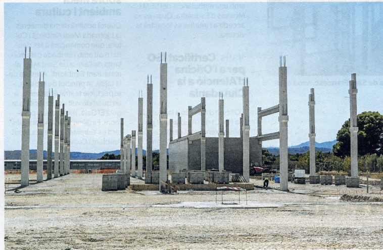
Estat de les obres de la nova nau que l'empresa està construint al polígon industrial. FOTO: JOAN REVILLAS
