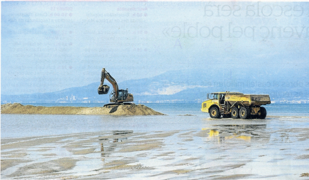
Aportació de sorres d'emergència a la barra del Trabucador. FOTO: JOAN REVILLAS
