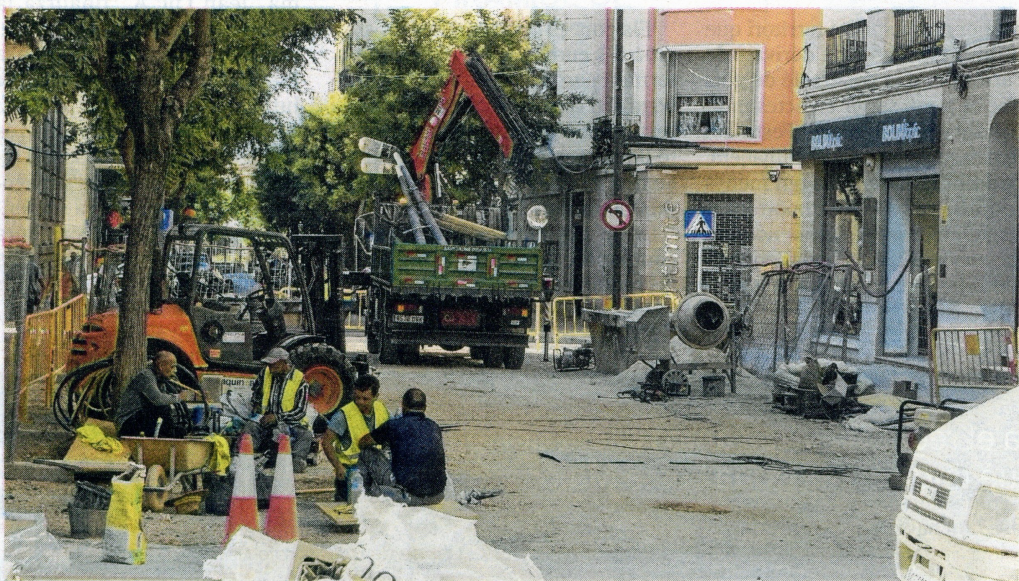
Ara el gruix de l'obra es troba al segon tram, entre el carrer Argentina i Berenguer IV. FOTO: J. REVILLAS
